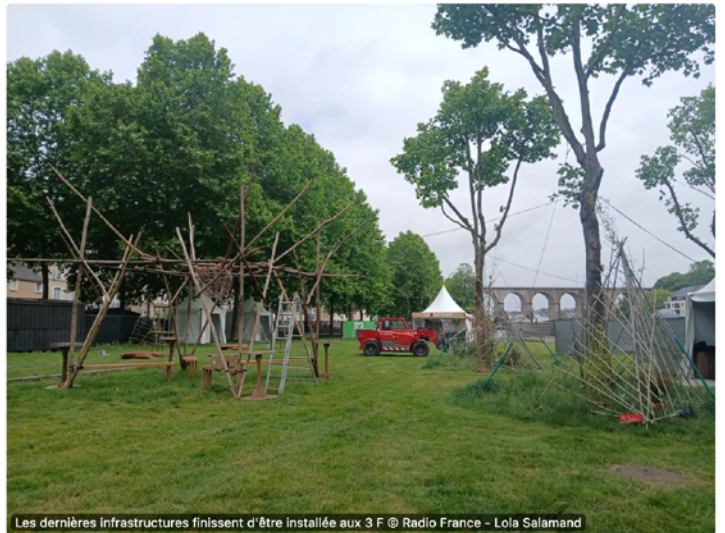
Les dernières infrastructures finissent d'être installées aux 3 F © Radio France - Lola Salamand
